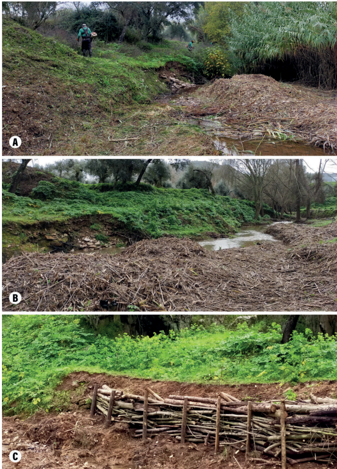
Figura n.º 17: Reconstituição de talude e margem através da técnica de engenharia biofísica “entrelaçados vivos” no ribeiro de Enxarrique, Vila Velha de Ródão.
