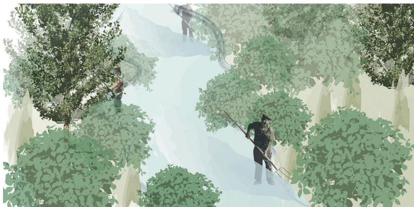
Figura n.º 18: Limpeza do interior do leito com recurso a meios manuais.
