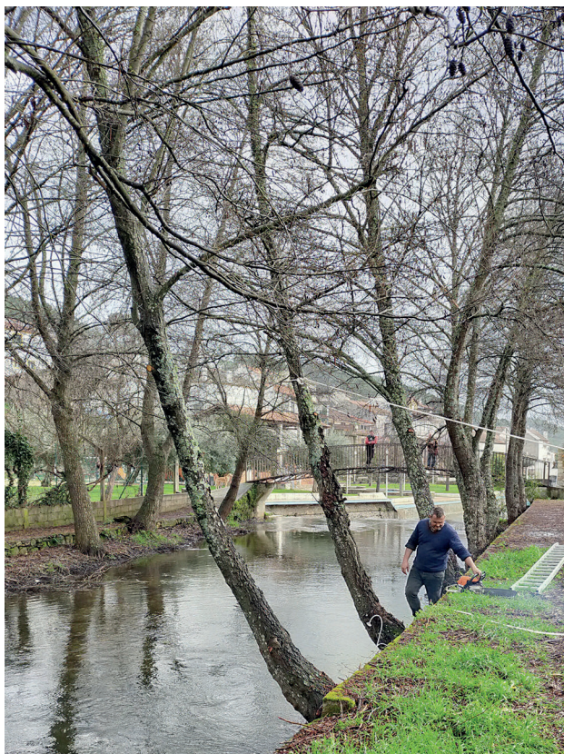
Figura n.º 29: Exemplos do corte conduzido, com recurso a cordas para orientação da queda, com mínimo interferência.
